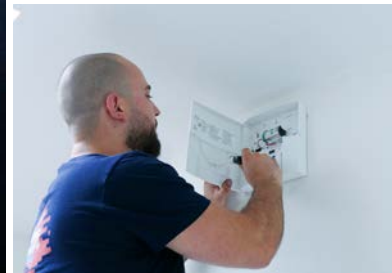
Marko Kolaric und Marvin Zweig wechseln die Wasser- und Wärmehähler aus.
