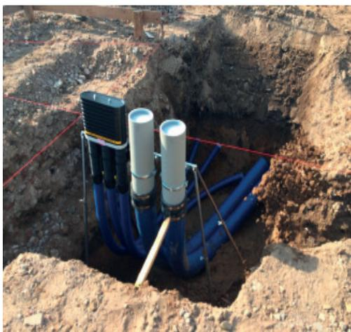
Beispiel einer Aufständigung von Schutzrohren, welche die Einführung von Hausanschlussleitungen nach der Erstellung der Bodenplatte ermöglichen sollen.
